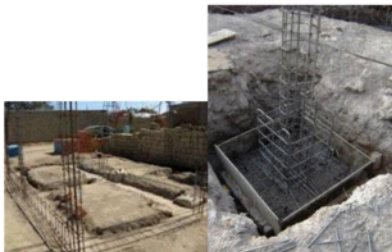
Cimentación de zapata aislada.
